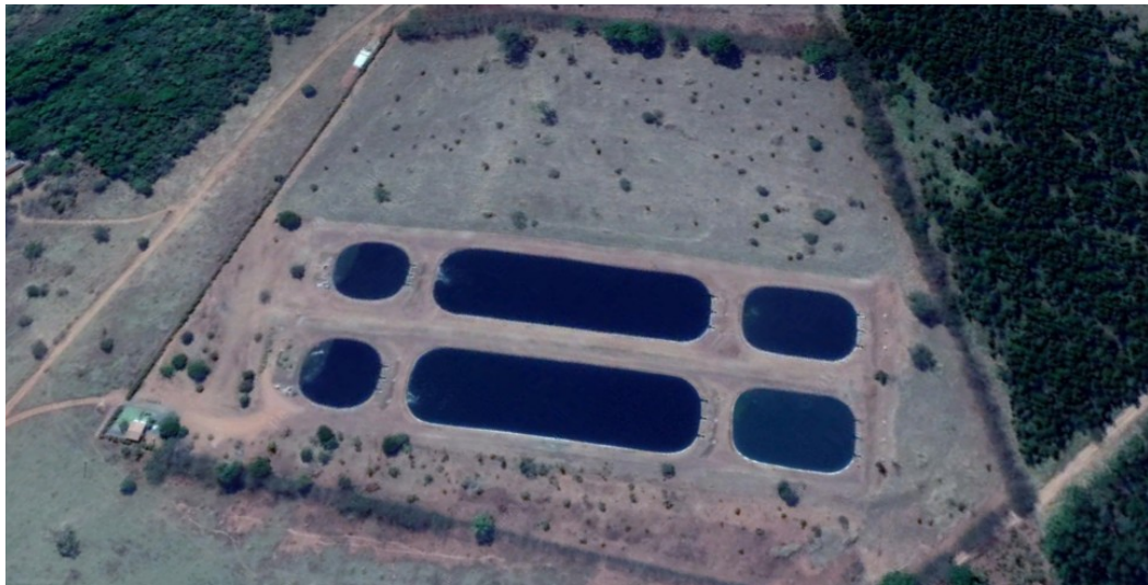
Figura 4 – Estação de Tratamento de Esgoto (ETE) Bela Vista
